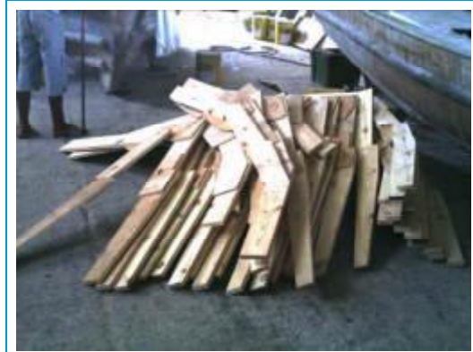
小生設計の6.5m作業船のオス型製作用フレーム
